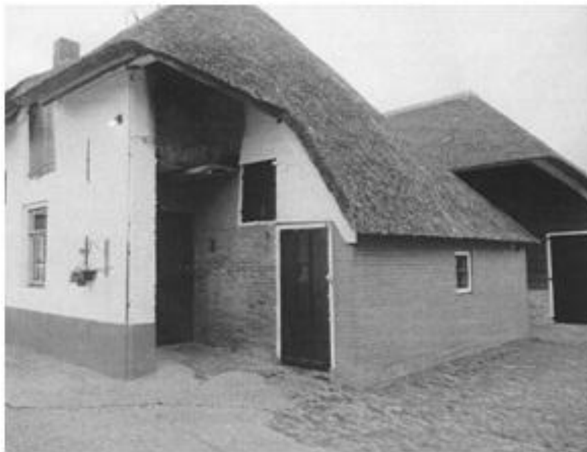
Achtergevel van het rechter- gedeelte (noordzijde). Deze is her- bouwd in 1998/1999.
